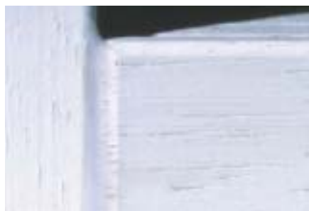
Защищенные V-швы с помощью Kodrin WV470
